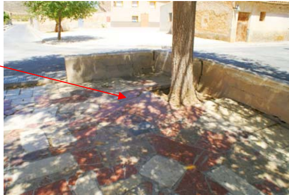
Pavimento de alrededor del alcorque levantado
