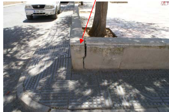
Murete abierto por empuje de raíces
