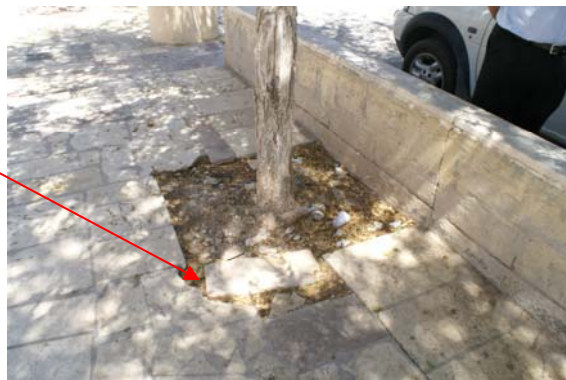
Pavimento de alrededor del alcorque suelto
